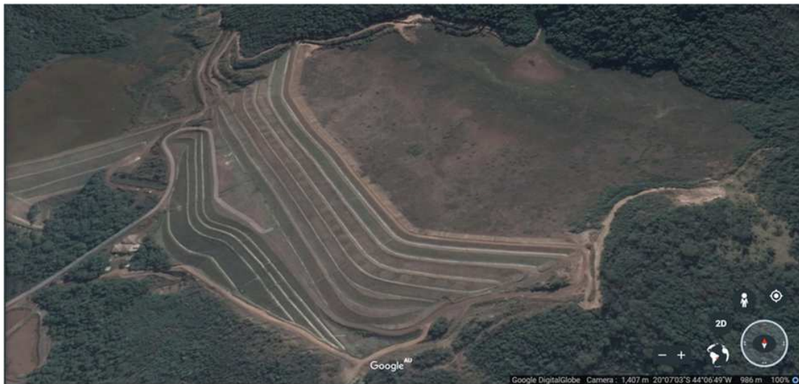
Figura 4: Barragem I, com vistas ao norte (fonte: Google Earth 3D, imagem de 7 de julho de 2018)
