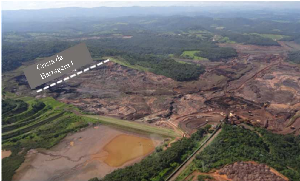
Figura 25: Vista aérea do rompimento da Barragem 1, aproximadamente na direção sudeste, fotografada em 28 de março de 2019
