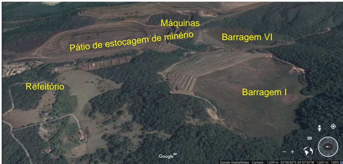
Figura 3: Localização da Barragem I, com vista para oeste (fonte: Google Earth 3d, imagem de 7 de julho de 2018 (texto acrescentado pelos autores))
