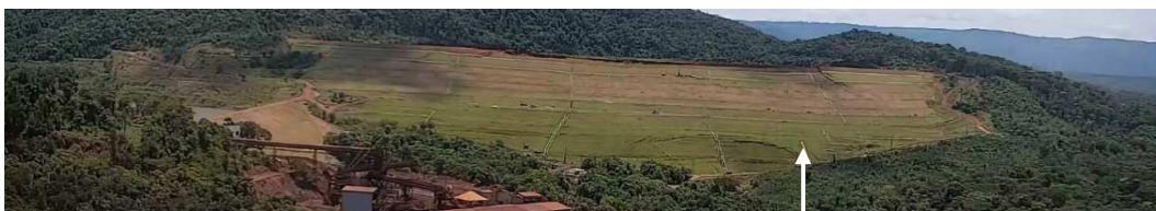
Figura 6: Abaulamento acima do pé da Barragem, aproximadamente a um terço da ombreira esquerda (lado direito da fotografia), iniciado cerca de 0,2 s após a primeira deformação observada na crista
