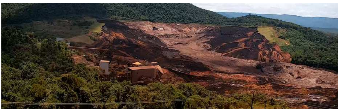
Figura 12: Regressão final do rompimento a 6 minutos e 25 s após a primeira deformação observada, conforme capturado pela CAM1
