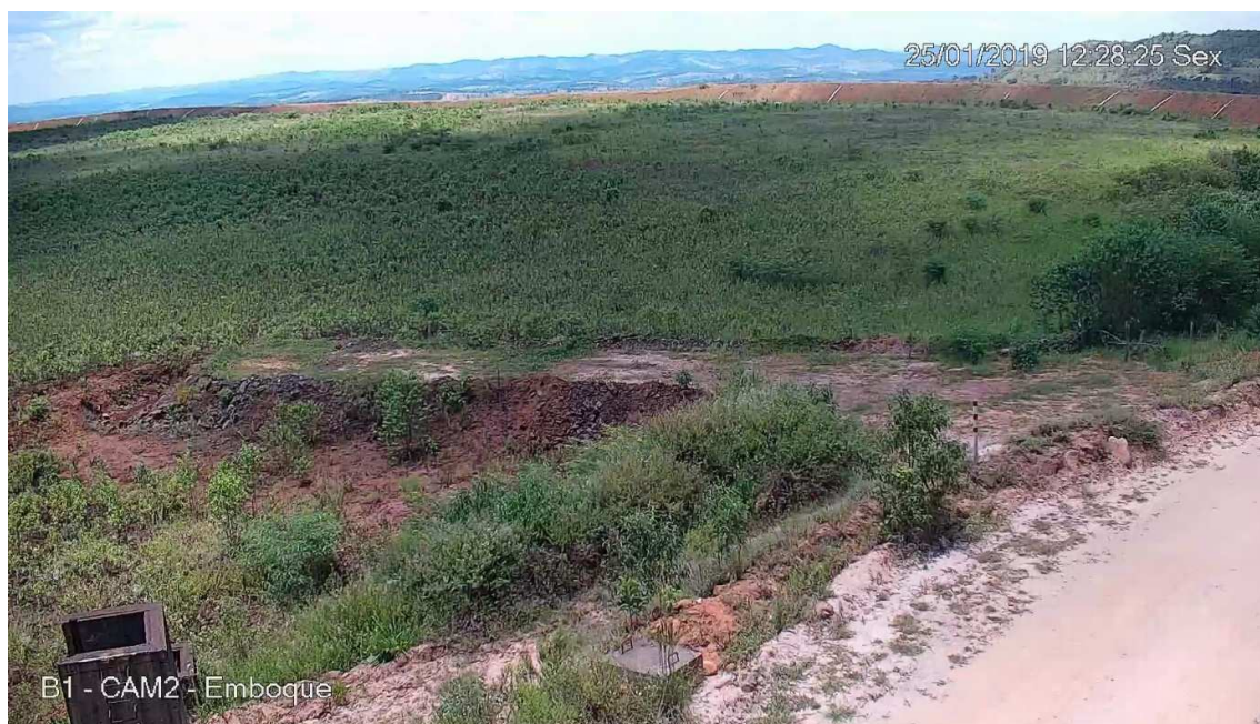
Figura 14: Recalque inicial da parte central da crista, capturada pela CAM2
