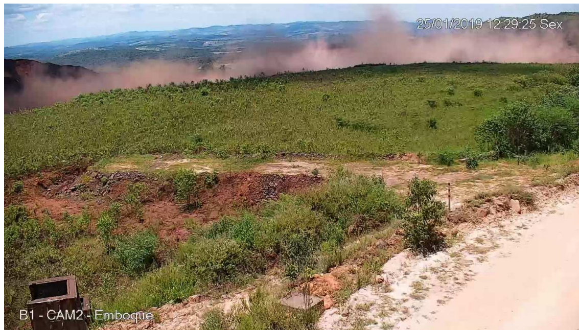
Figura 15: Regressão do rompimento de liquefação aos 60 s após a primeira deformação observada, conforme capturada pela CAM2
