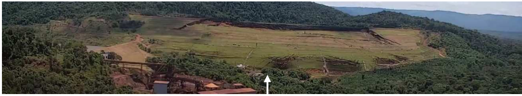
Figura 7: Continuação do recalque da crista e abaulamento acima do pé com erupção de água acima do pé da barragem em direção à ombreira direita (lado esquerdo da fotografia), cerca de 5,5 s após a primeira deformação observada na crista
