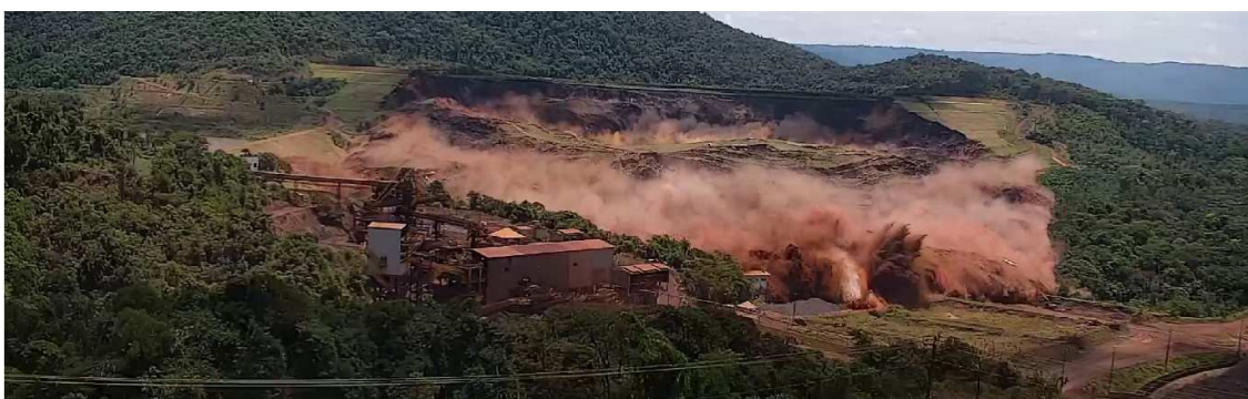
Figura 11: Regressão do rompimento a 18 s após a primeira deformação observada, conforme capturado pela CAM1
