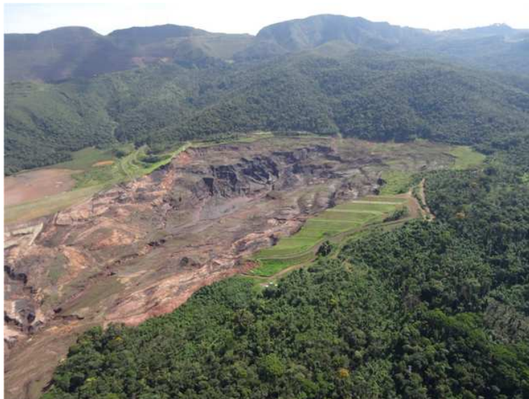
Figura 26: Vista aérea do rompimento da Barragem 1, em direção ao norte, fotografada no dia 28 de março de 2019
