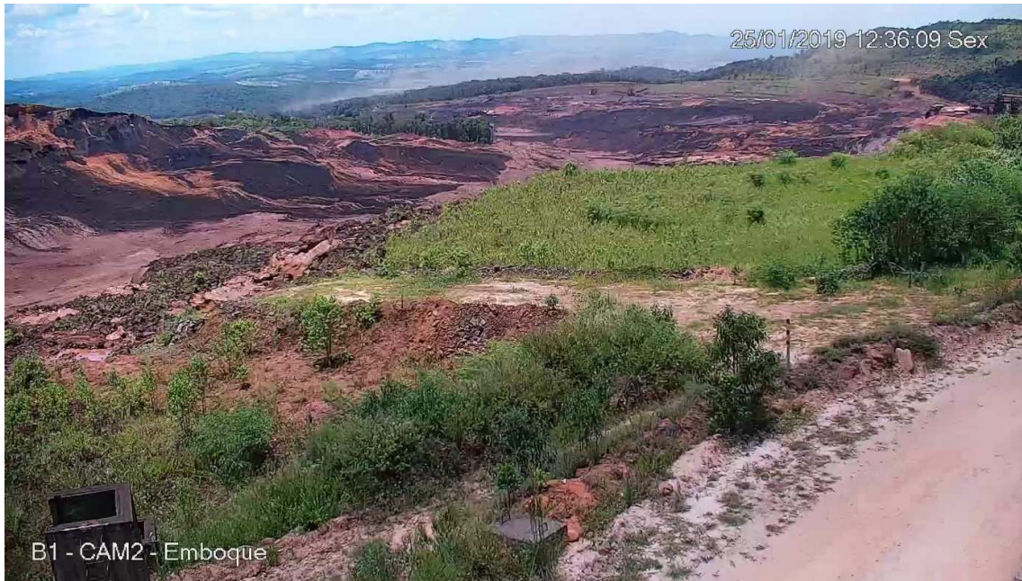
Figura 17: Regressão final do rompimento por liquefação 7 minutos e 44 s após o início da primeira deformação observada do rompimento, conforme capturado pela CAM2
