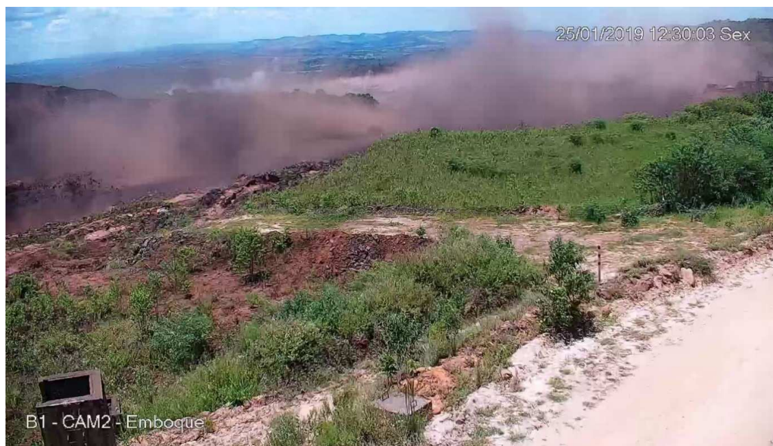
Figura 16: Regressão do rompimento de liquefação aos 98 s após a primeira deformação observada na crista, conforme capturada pela CAM2
