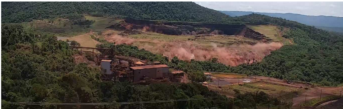
Figura 10: Regressão do rompimento a 11 s após a primeira deformação observada, conforme capturado pela CAM1
