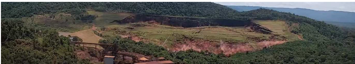
Figura 9: Desenvolvimento completo do rompimento do talude, com rompimento em massa movendo além do pé da barragem, a cerca de 6,7 s após a primeira deformação observada na crista
